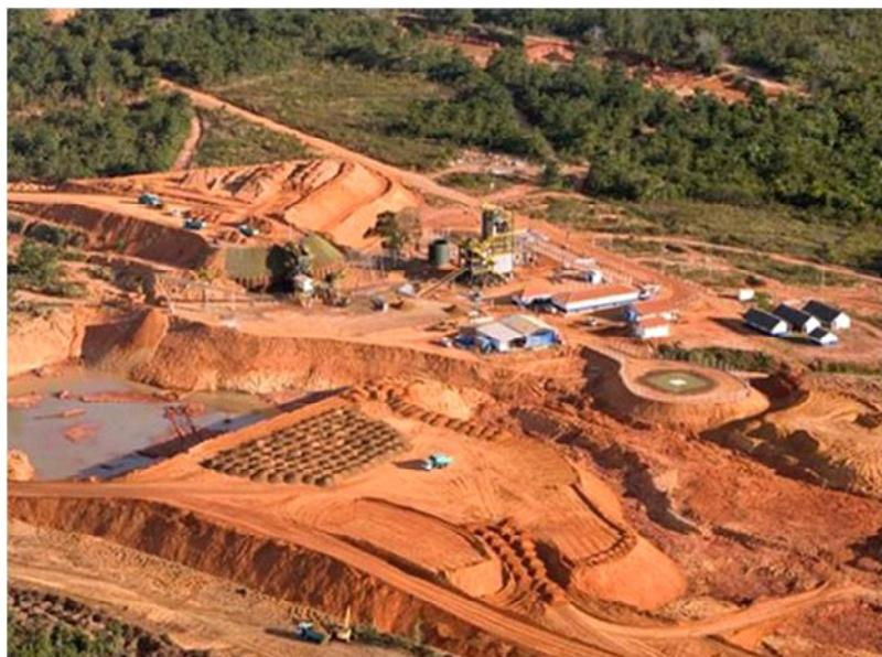
Figura 20. Mina do Quilombo – Chapada (Vaaldiam) - Detalhe da Frente de Lavra, da Planta de Tratamento da bacia de rejeitos à esquerda. Foto extraída da web site [www.vaaldiam.com](http://www.vaaldiam.com).
