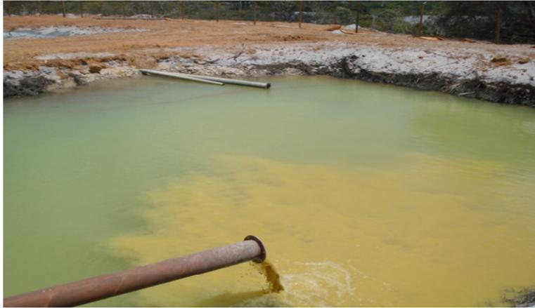
Figura 34. Água sendo depositada em tanque de decantação e tratada em três tanques em seqüência (Foto SAMSUL Bahia 2008)
