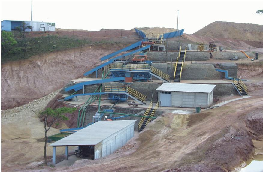
Figura 53. Planta aluvionar para  $30\text{ m}^3/\text{hora}$  da SAMSUL Mineração com jiges e mesas de graxa em Coromandel – MG (Foto Mario Freitas)
