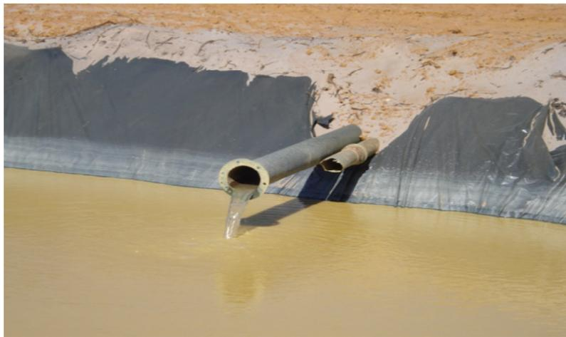
Figura 35. Água sendo depositada em tanque de decantação e tratada em três tanques em seqüência (Foto SAMSUL - Bahia 2008)
